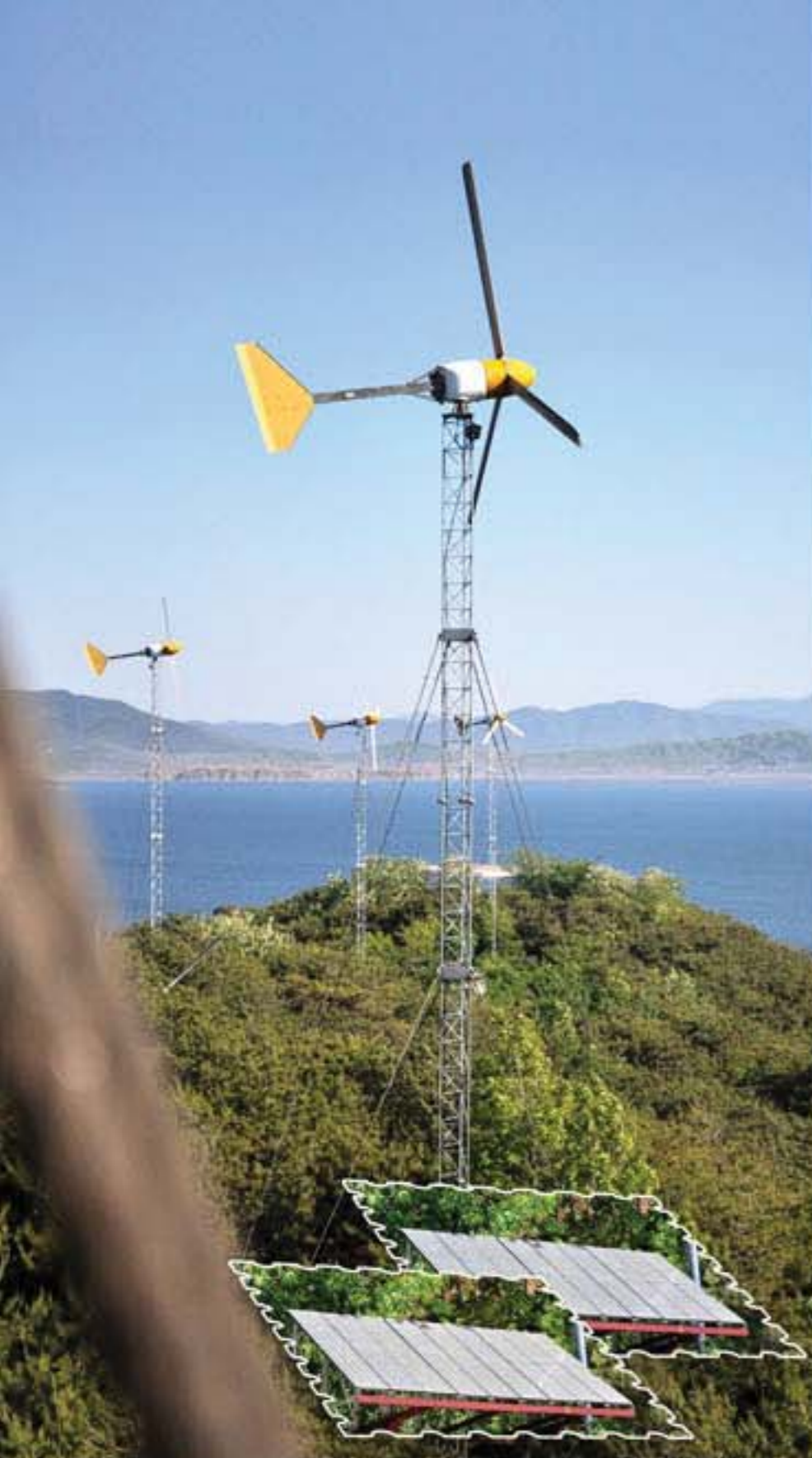
На заводе при использовании ветроэлектрических генераторов, панелей солнечных батарей вырабатывают электроэнергию для хозяйственной деятельности.
